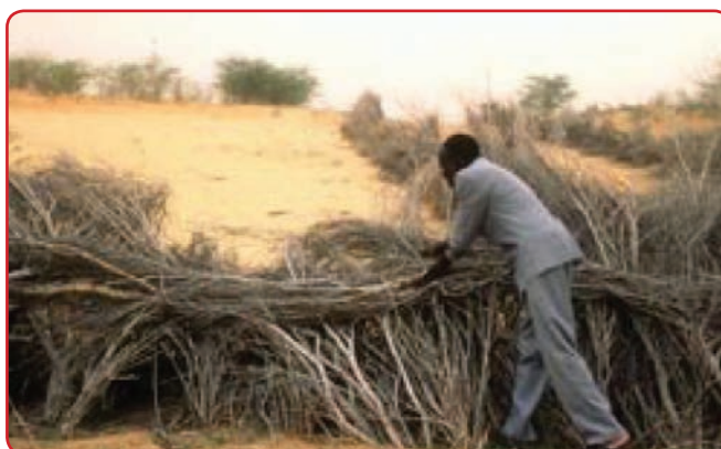
Construcción de barreras (cercos) para prevenir el avance de las dunas de arena en Gour, África. Los cercos están contruidos principalmente con el arbusto local ( pyrothec-nica leptadenia ) o con las hojas de palma secas.
